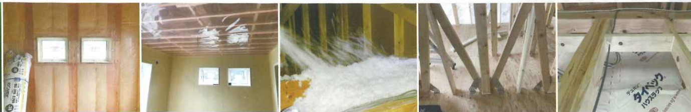
左から、図1 グラスウールマイスター認定制度、写真1 別張りグラスウール施工、写真2 壁の先行施工、写真3 天井内がラウール吹き込み施工、写真4 1階床の柱まわりシールにて気密処理、写真5 木材とシールで気流止め
